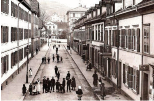
Blick 1905 in die Palmstraße Richtung Bahnhofsvorplatz
